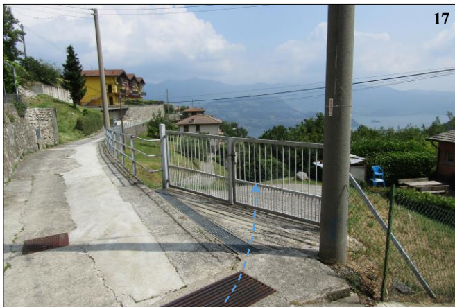
Posizione 17: ripresa dall'alto verso il basso: dettaglio dell'immagine precedente, in cui si vede il punto di fuoriuscita delle acque dalla griglia e la prosecuzione delle stesse lungo la linea di massima pendenza nell'impiuvio sottostante; il percorso delle acque cartografato nel RIM è indicato in blu
